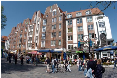
Hansestadt Rostock, Universitätsplatz mit Fünfgebäudehaus Foto: Hansestadt Rostock/Fotoagentur nordlicht
