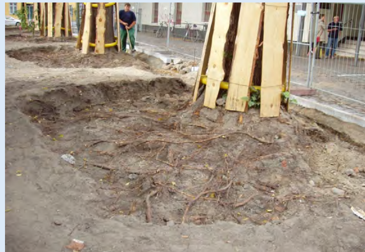
Oberboden Absaugen/Austausch
