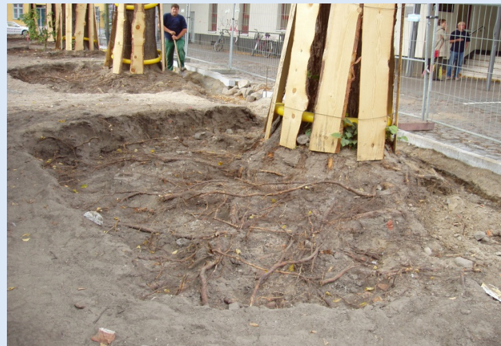
Oberboden Absaugen/Austausch
