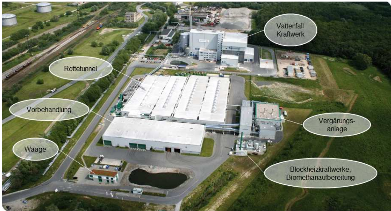
Abb. 2: Mechanisch-Biologische Abfallbehandlungsanlage (MBA) Rostock [Quelle: Veolia Umweltservice Nord GmbH]
