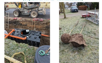
Beispiel: Einbau von Baum-Rigolen am Fritz-Mackensen-Weg (Foto: Uni Rostock)
