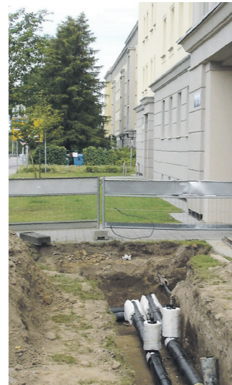
Verlegung von Fernwärmeleitungen in Reutershagen
