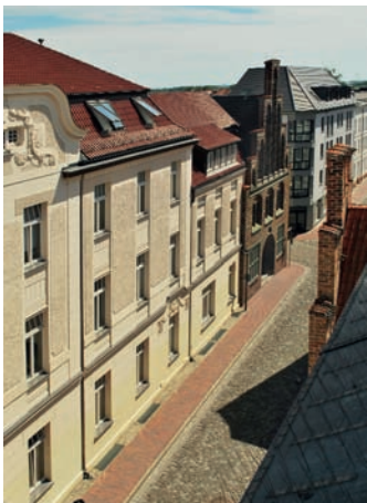
Stadthaus und Kerkhofhaus
