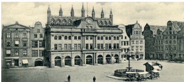
Das Rathaus nach der Rekonstruktion von 1901/02. Die Maßwerkrosetten in der Schauwand wurden geöffnet.
