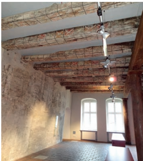
Reste der Wandmalerei und bemalte Deckenbalken im Neuen Haus
