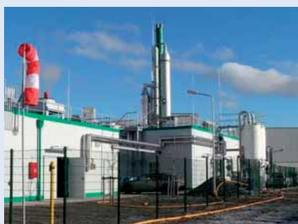
Biogasauf- bereitungs- anlage und Bioerdgas- einspeise- station
