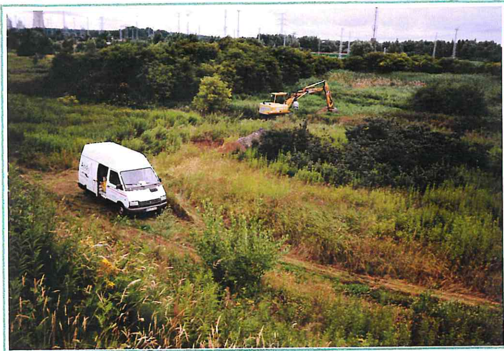
Anlegen von Baggerschürfen im Bereich der ehemaligen Güllelagunen
