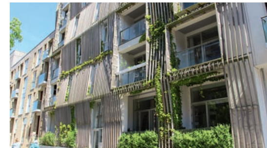
Innovativer Wohnungsbau prägt den Norden des Stadtparks.
