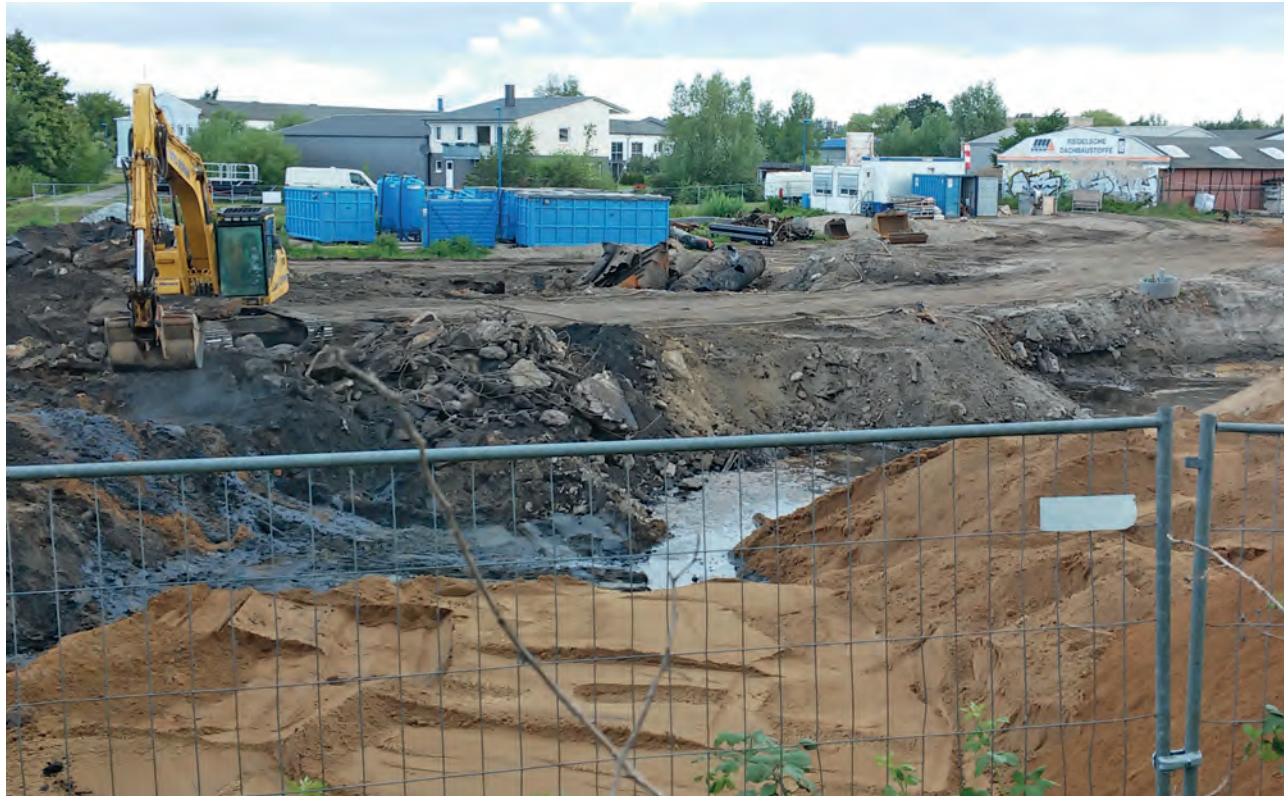
Altlastensanierung am Warnowufer
