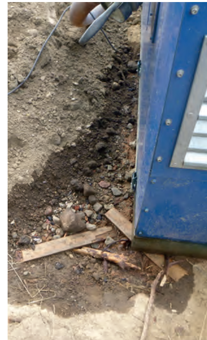
Schädliche Bodenveränderung durch ausgelaufenen Dieseldieselkraftstoff
