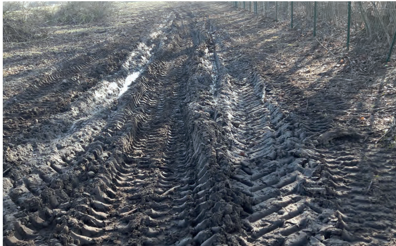
Schädigung des Oberbodens durch Bautätigkeit
