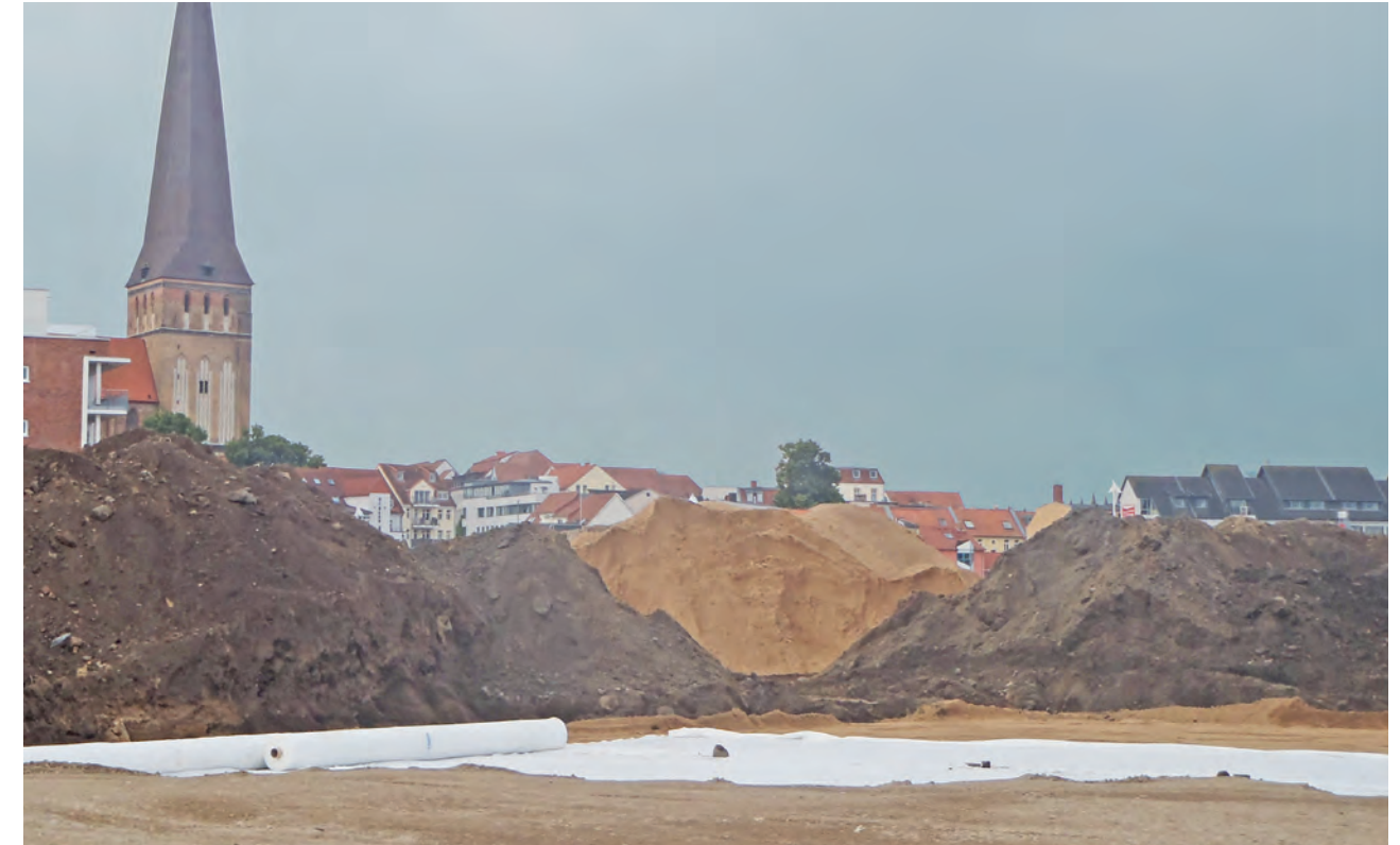
Bodenhauferwerke im Zuge einer Baumaßnahme im Stadtzentrum
