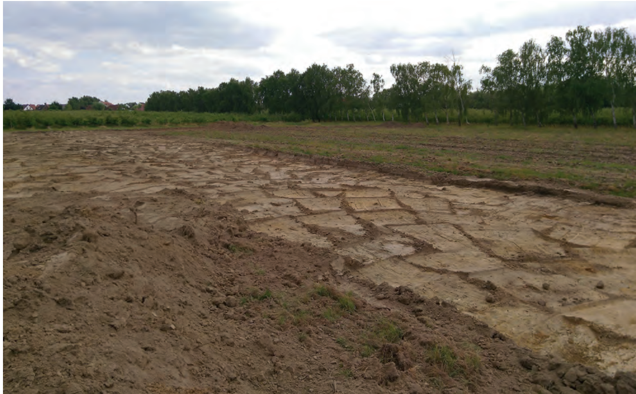
Vorbereitung einer Bodenverbringungsfläche
