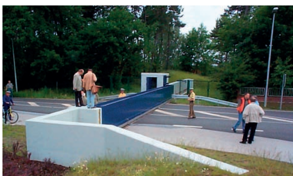
Sturmflutschutztor am Wohngebiet Tonnenhof/Hohe Düne
