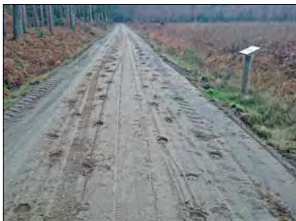
Abb. 39: Schäden am soeben instandgesetzten internationalen Radwanderweg durch illegalen Beritt
