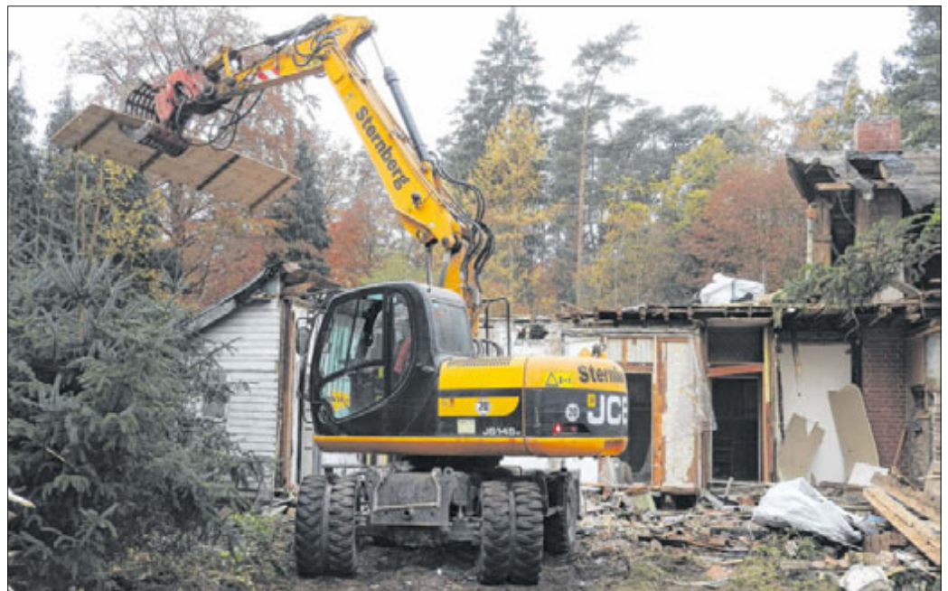
Die Gebäuderuinen am Wallensteinslager werden abgetragen.
