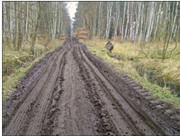
Abb. 47: Rosenortschneise – ein ausgewiesener Rad- und Wanderweg – nach der Aufarbeitung der Sturmschäden
