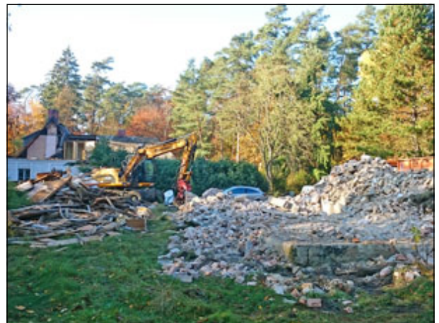
Abb. 38: Abriss der Liegenschaft „Wallensteins Lager“
