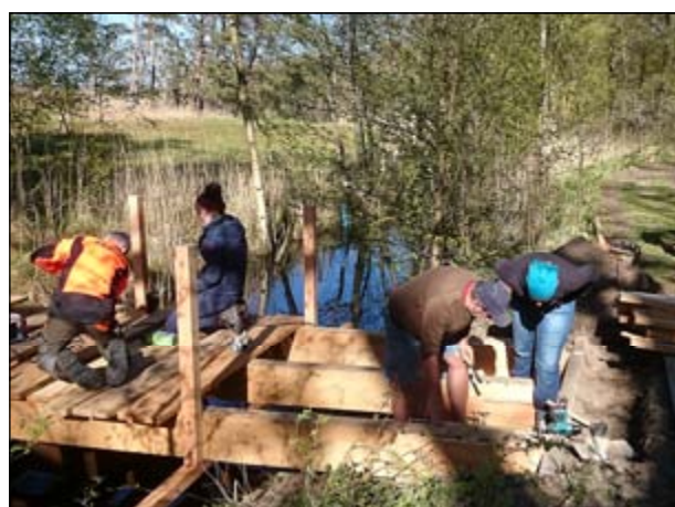
Abb. 43: Bergwaldprojekt – Neubau der Brücke an der Staustufe im NSG „Heiligensee und Hütelmoor“
