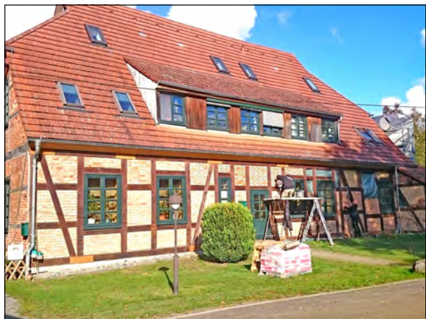
Abb. 79: Rekonstruktion des Fachwerks am Forstamtsgebäude in Wiethagen
