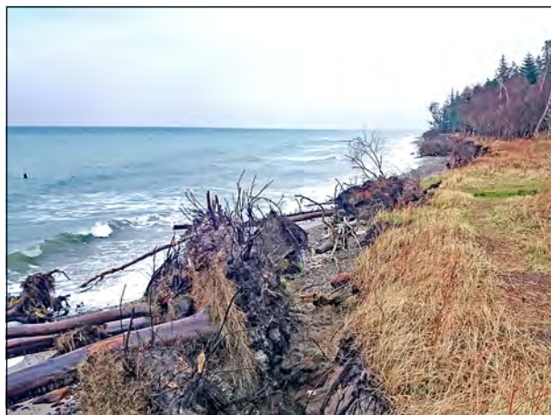
Abb. 58: durch Küstenrückgang gefährdeter Weg
