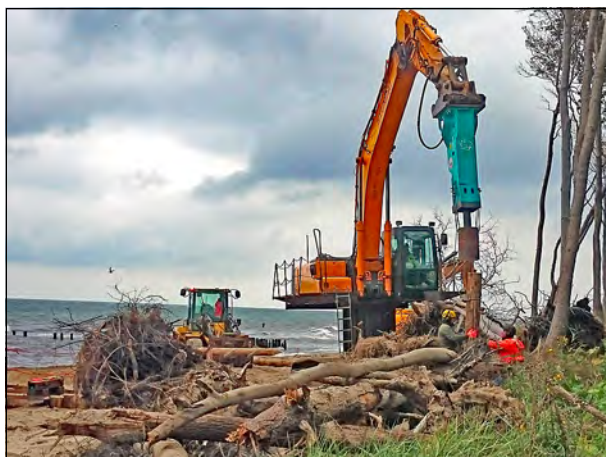
Abb. 59: Bühnenbau im Revier Torfbrücke
