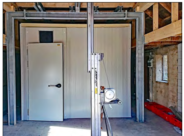
Abb. 76: Wildkühlzelle und Zerlegeraum in Hinrichshagen (im Bau)
