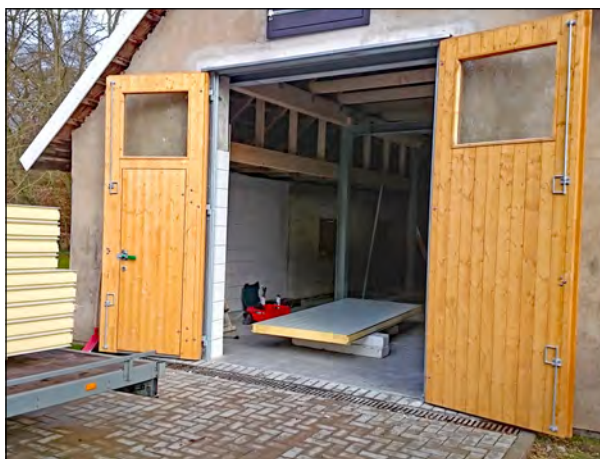
Abb. 80: Bau der Wildkühlzelle an der Revierförsterei Hinrichshagen
