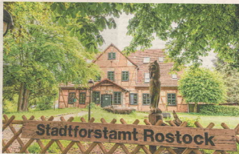
Der alte Forsthof des Rostocker Stadtforstamtes soll klimaneutral saniert und erweitert werden.
