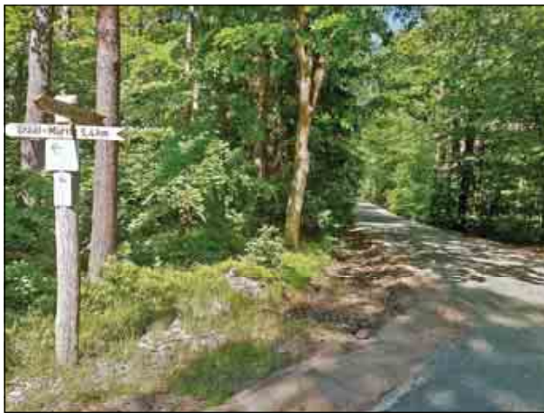
Abb. 51: Ostseeküstenradweg nach grundlegender Instandsetzung
