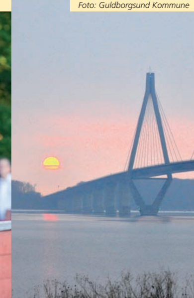
Farø Brücke Guldborgsund, Foto: Guldborgsund Kommune
