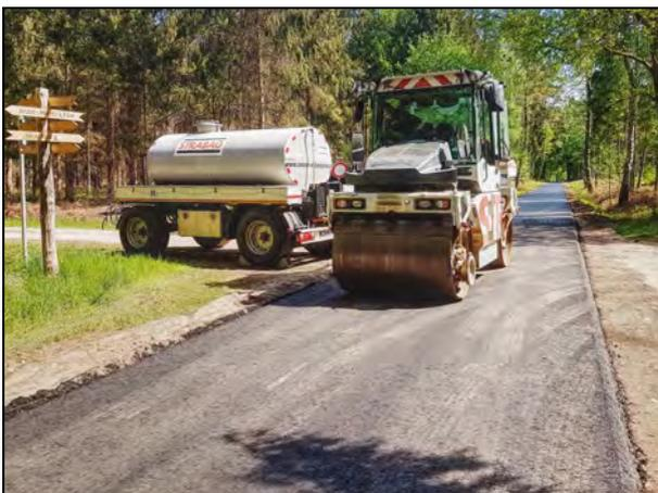
Abb. 54: Wegeinstandsetzung in gleicher Bauweise und Dimension
