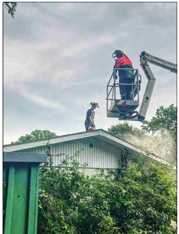
Abb. 29: Aufarbeitung Sturmschäden an Gebäuden (hier: Stoltera)
