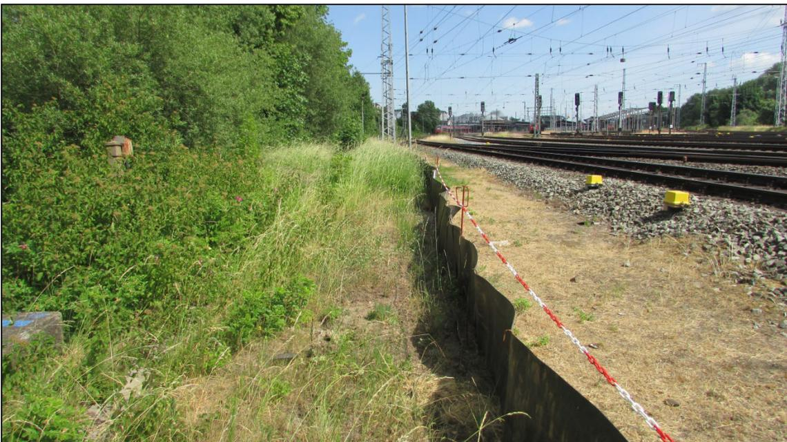
Foto 8: Bereits installierte Reptilien- und Amphibienschutzzaun entlang der Strecke
