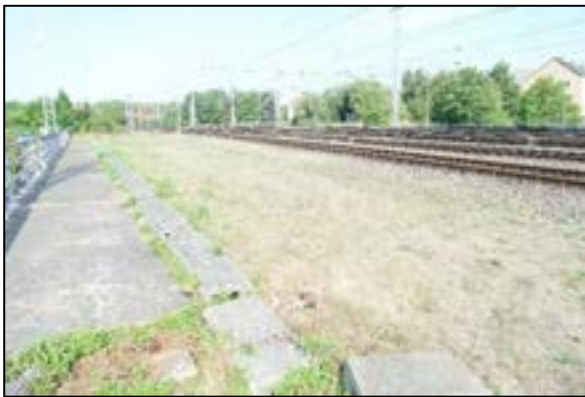
Abbildung 4: EÜ Goetheplatz mit Blick nach Westen [34]
