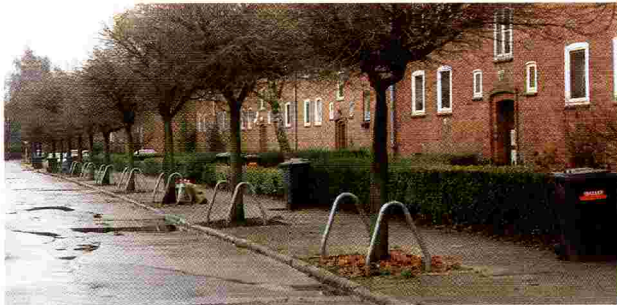
Einbau von Baumschutzbügeln
