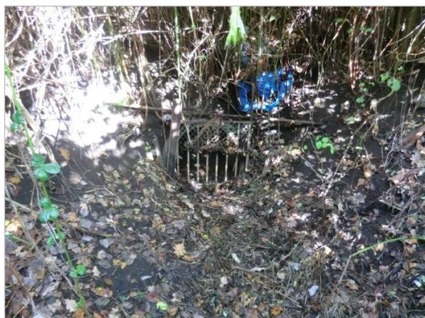
Einlauf der Rohrleitung nahe Feuerwehr, DN800
