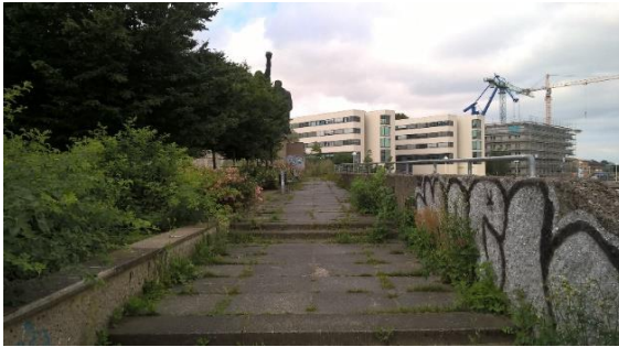
Gehwege im Bereich Matrosendenkmal
