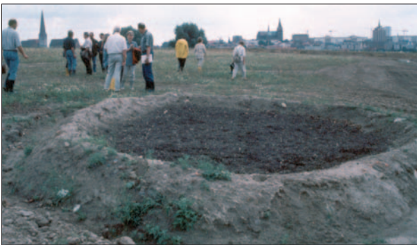
Gasfenster der Deponie Dierkow, inzwischen begrünt.
