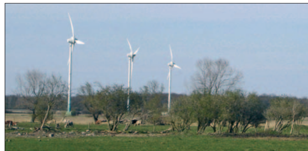
Drei von fünf Windkraftanlagen in Rostock-Stuthof
