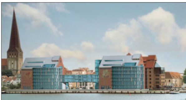
Das Büro- und Geschäftshaus der Silohalbinsel am Stadthafen nutzt Erdwärme (© H.S.W. GmbH)
