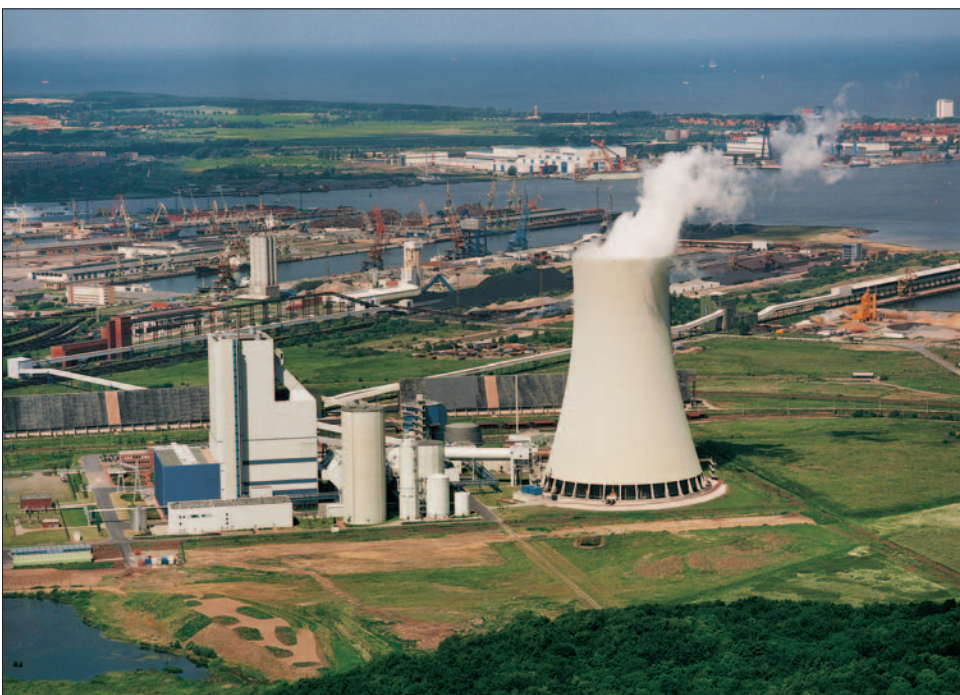
Steinkohlekraftwerk der KNG (© KNG mbH)
