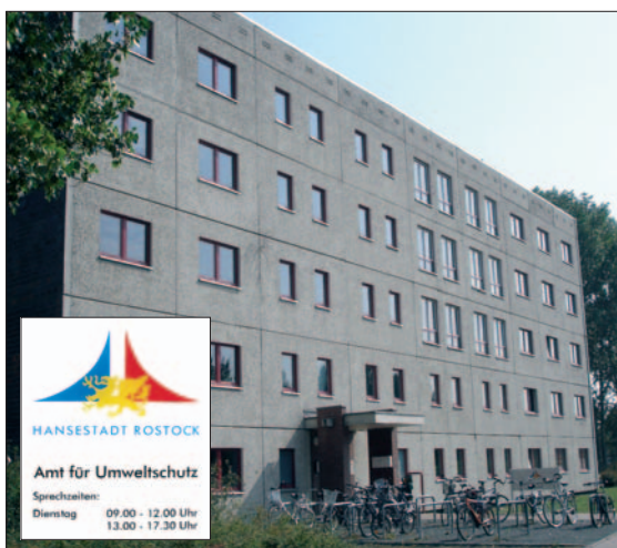
Umweltamt im teilsanierten Plattenbau, gut untersucht für EMAS-Zertifizierung des Amtes
