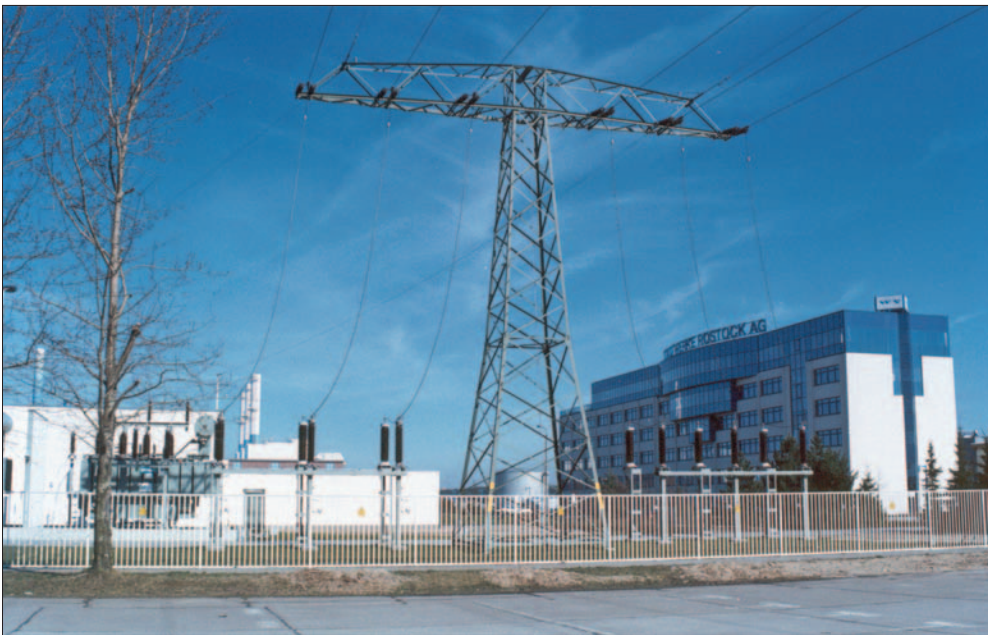
Das Herz der Rostocker Energieversorgung: Heizkraftwerk der Stadtwerke
