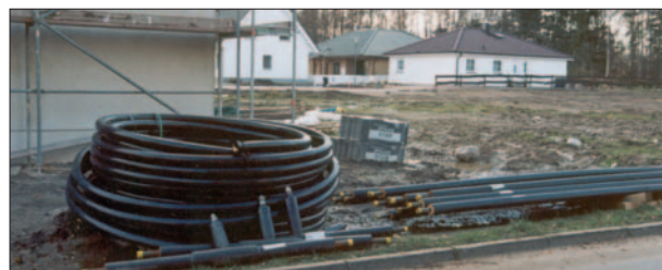
Fernwärmeverlegung in Evershagen-Süd
