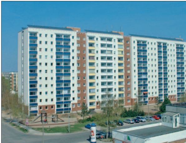
PV-Anlage auf dem Vitushaus in Schmarl (90 kWp)
