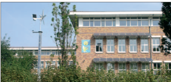
Käthe-Kollwitz-Gymnasium, saniert. Teilnahme am Energiesparwettbewerb; auch Regenerativnutzung
