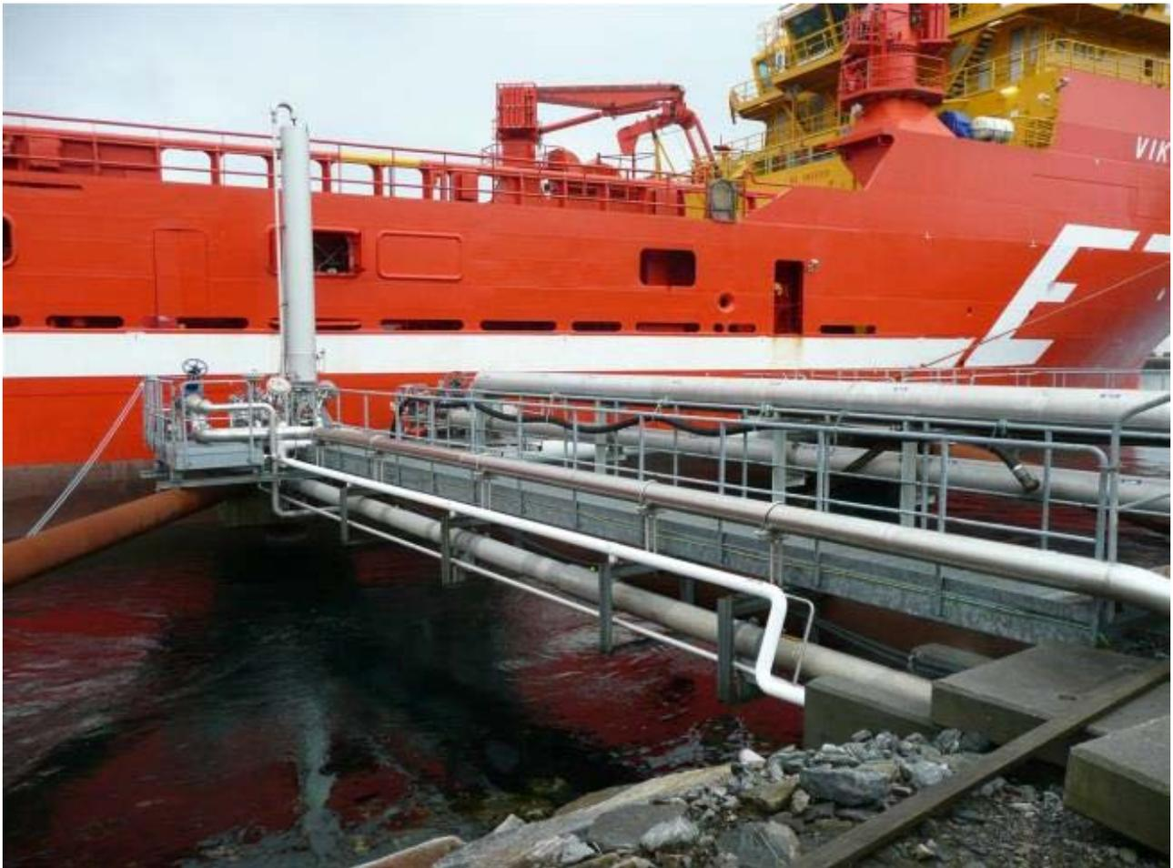
Abbildung 16: Pipe-To-Ship Bebunkerung der Viking Energy
