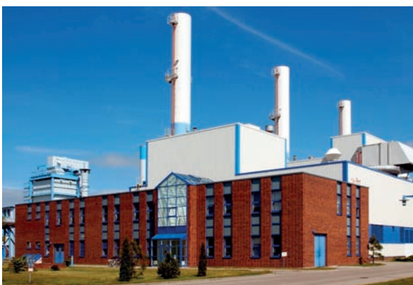
Das moderne Heizkraftwerk versorgt große Teile der Stadt mit Wärme.
