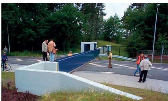
Sturmflutschutztor am Wohngebiet Tonnenhof/Hohe Düne
