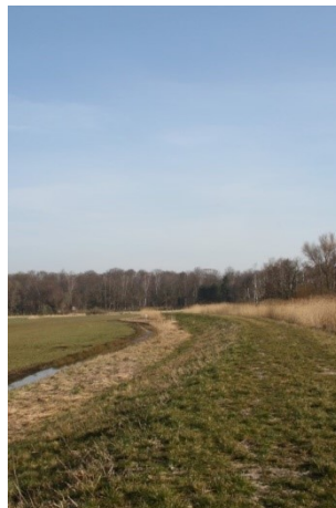
Einsatz im Deichbau
