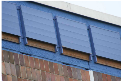
Kombination aus Erhalt von Fledermausspaltenquartieren (waagerechte Schlitze an der Klinker-oberkante) und Fledermausspaltenkästen an einem Plattenbau in Rostock-Dierkow
