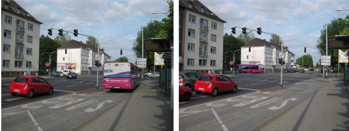
Abbildung 86: Busschleuse an einem Knotenpunkt mit Haltestelle für linksabbiegenden Bus (Beispiel: Mönchengladbach)
