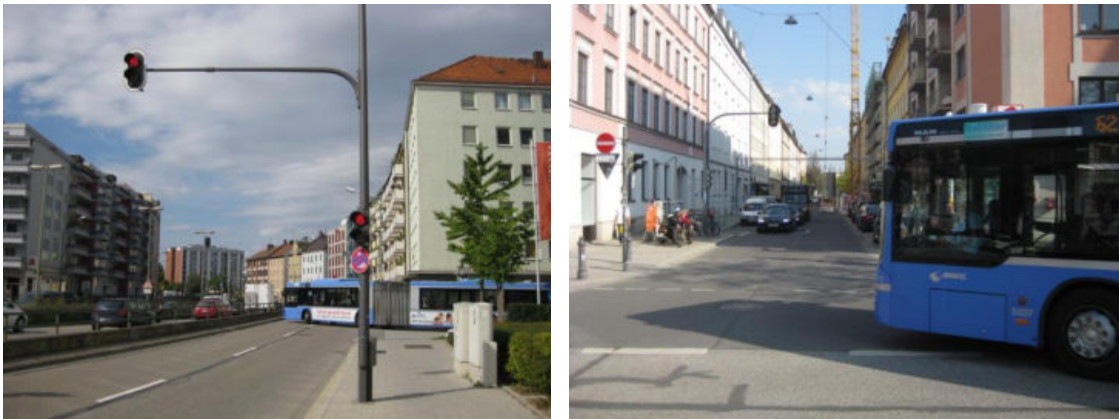
Abbildung 87: Abfangsignalisierung (linkes Bild; Beispiel: München) und Engstellensignalisierung (rechtes Bild; Beispiel: München)
