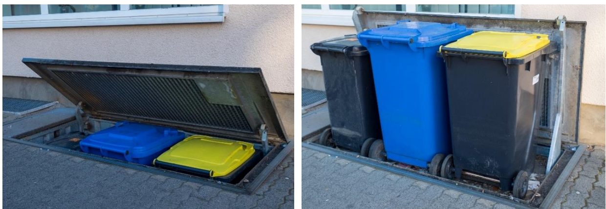
Beispiel für einen versenkbaren Behälterstandplatz mit Zweiradbehältern im Ortsteil Kröpeliner-Tor-Vorstadt
