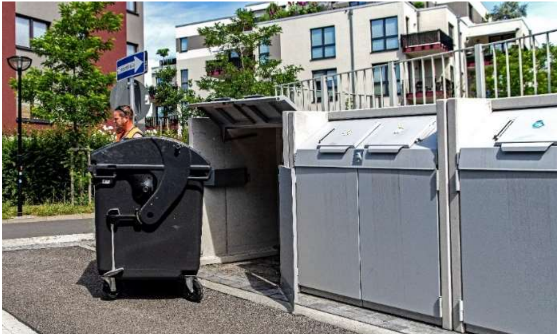
Beispiel für einen Behälterstandplatz mit Vierradbehälter in Betonboxen im Ortsteil Stadtmitte
