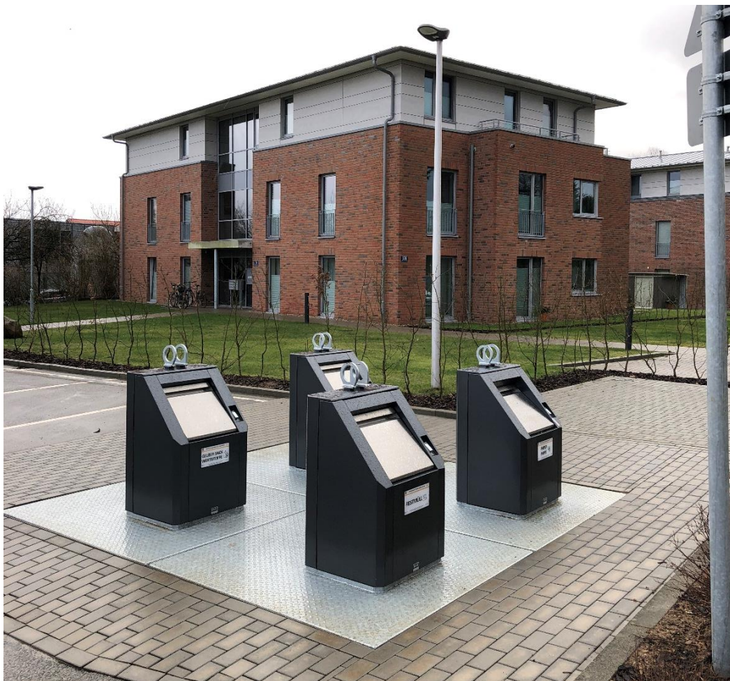
Das Unterflursystem führt zu einer sauberen und aufgeräumten Wohnumgebung. (13)
