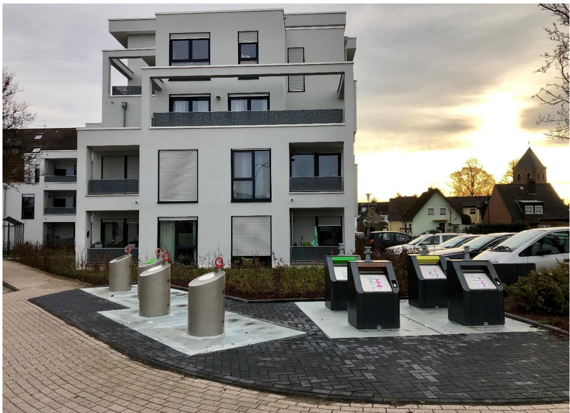
Unterflursystem in einer Wohnanlage in Rendsburg (2)
