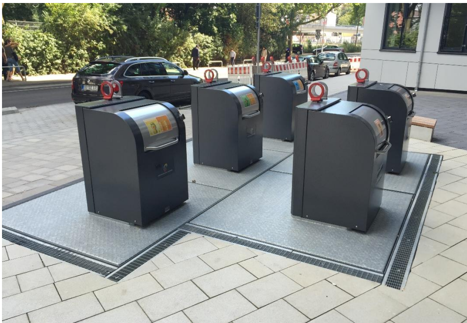
Fünf Unterflurbehälter versetzt im Block angeordnet. (Alle Angaben sind Circa-Maße in Meter und können abweichen). (10)
