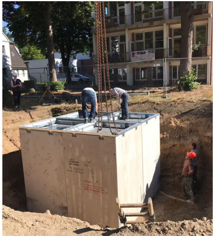
Aushub der Baugrube mit Verbau (links) und Einlass der Betonschächte in die Baugrube ohne Verbau (rechts). (5)
