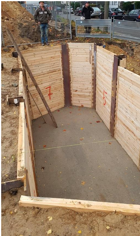
Aushub der Baugrube mit Verbau (links) und Einlass der Betonschächte in die Baugrube ohne Verbau (rechts). (5)
