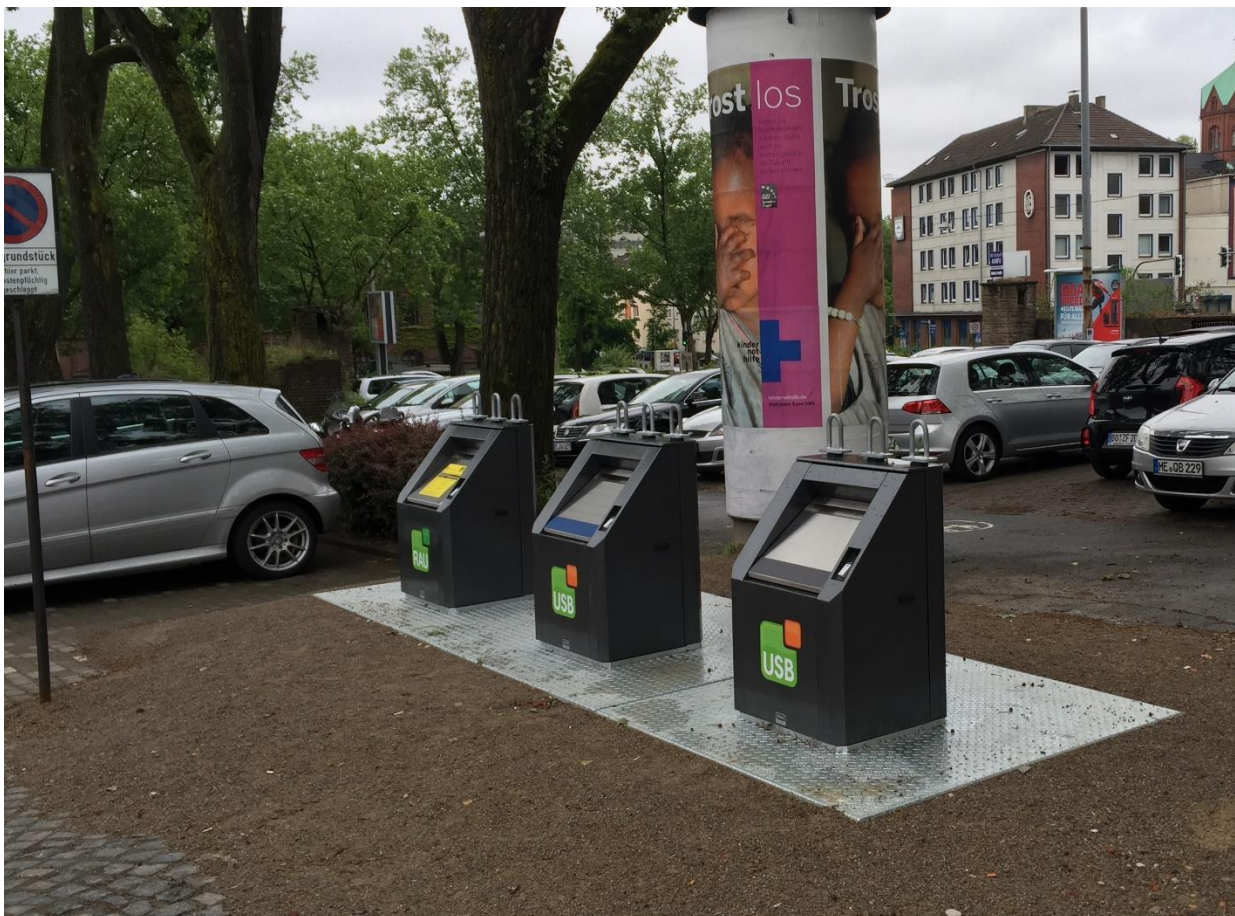
Das Unterflursystem erreicht eine deutliche Platzeinsparung durch den Wegfall von sperrigen Abfallgroßbehältern. (14)
