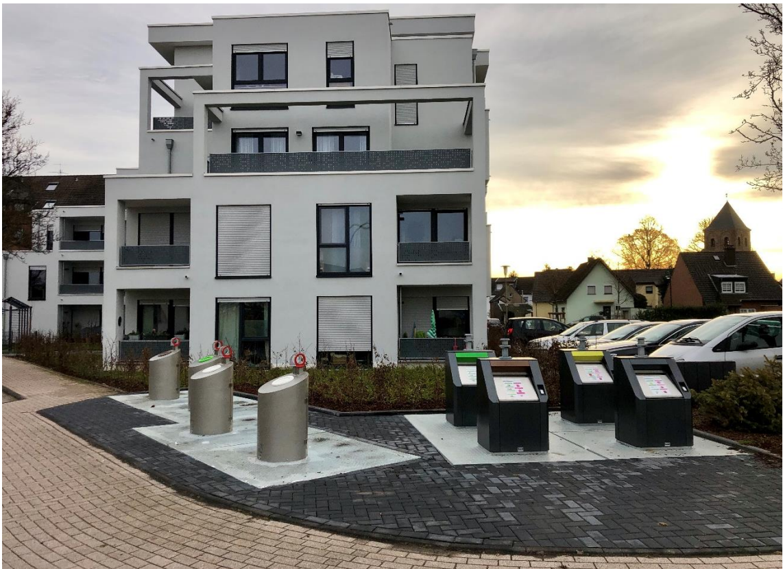
Unterflursystem in einer Wohnanlage in Rendsburg (2)
