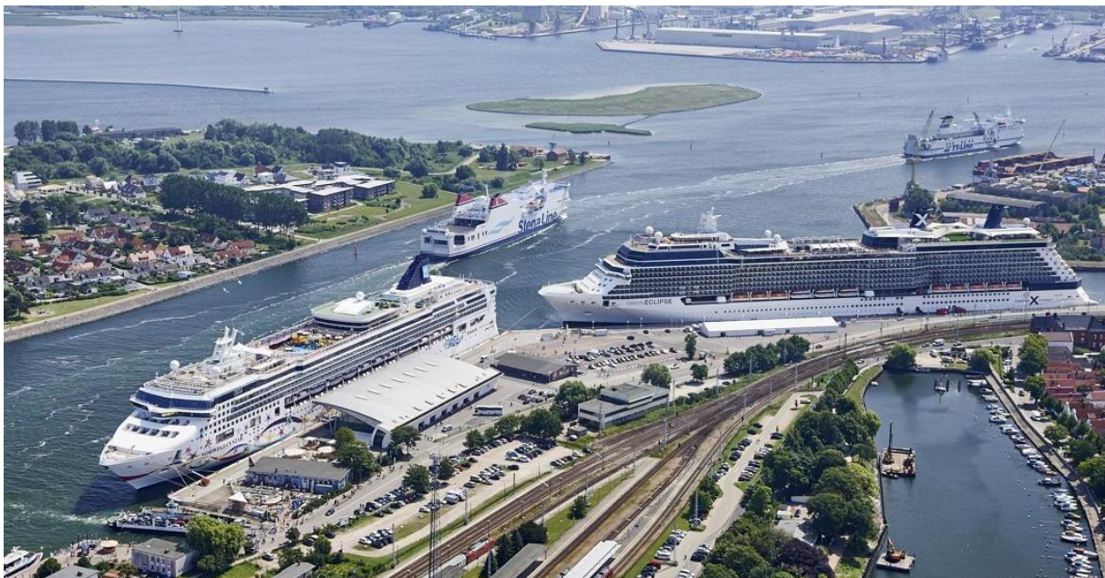
1. Räumlicher Bezug (Luftbild 2015), Liegeplatz 7 mit bestehendem Terminalgebäude und Liegeplatz 8 mit Provisorium
