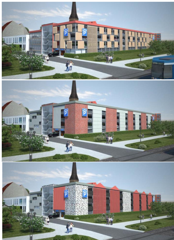
5. Fassadenverkleidungen, Beispiele der WIRO
