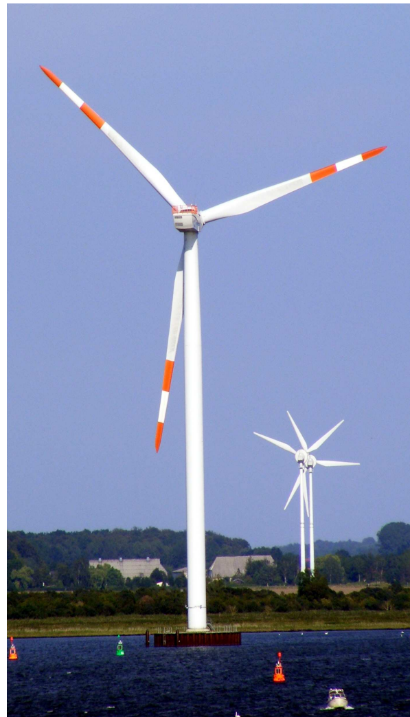
Foto: Offshore-Versuchsanlage im Vordergrund und dahinter ein Teil des Windparks Rostock-Stuthof
