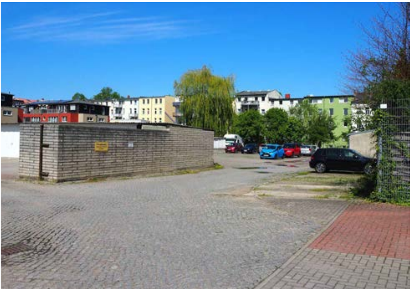
Abb. 72. Versiegelter Blockinnenbereich (Waldemarstr./Ulmenstr./Margaretenstr.)
