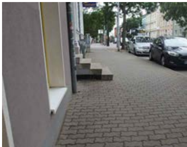
Abb. 59. Fehlender Kontrast zwischen Treppenstufen und Gehweg
