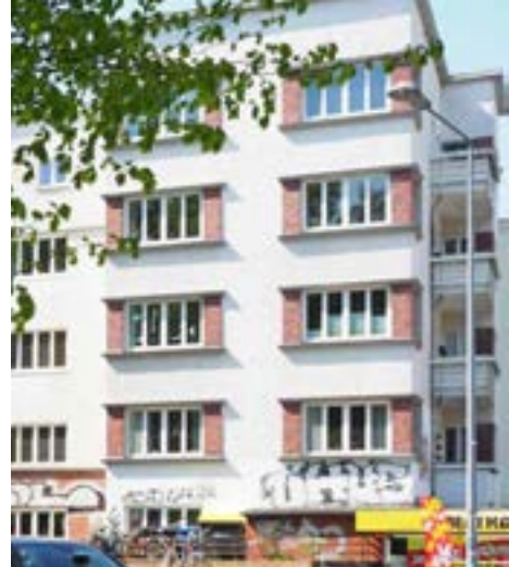
Abb. 31. Gebäudebestand erbaut vor 1945
