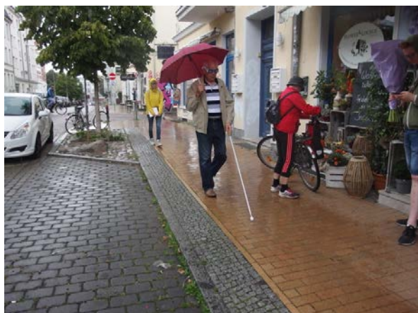
14 Visuell und taktil erkennbare Trennung von Gehweg und Fahrbahn
