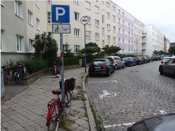
11 Behindertenparkplatz ohne abgesenkten Bordstein
