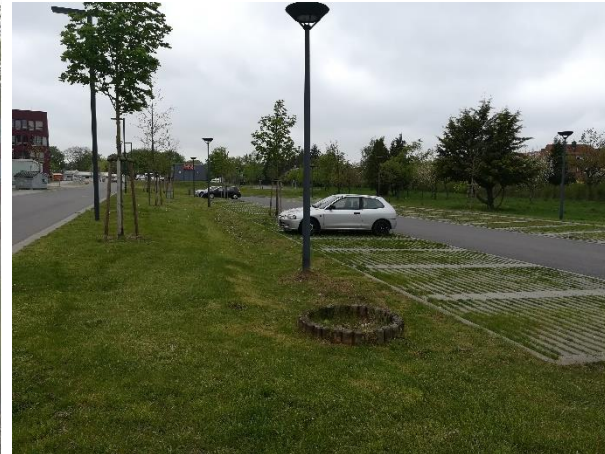
Versickerungsmulde in Grünfläche integriert und teilversiegelter Parkplatz am Unicampus Rostock - Südstadt
