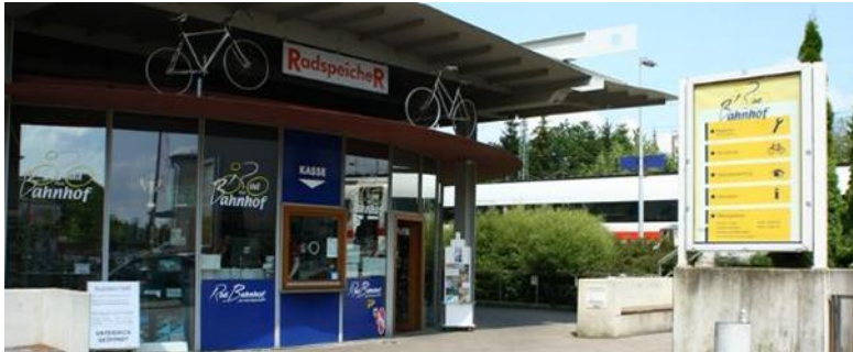
Abbildung 35: Kombinierte Abstell- und Servicestation Lüneburg
