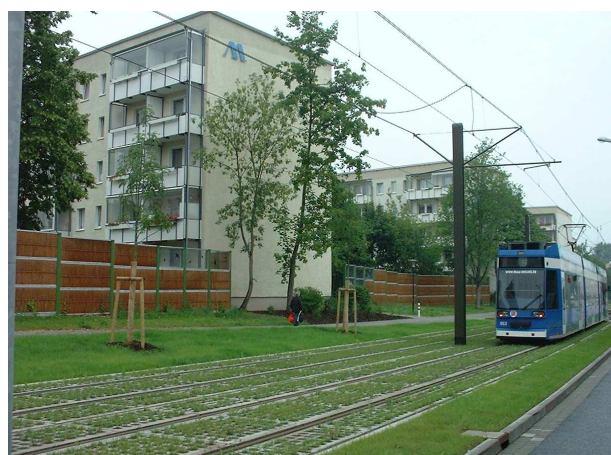
Foto: Lärmschutzmaßnahmen an der ausgebauten Nobelstraße
