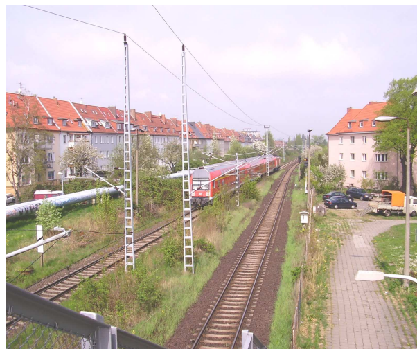
Foto: Teil des Sanierungsbereiches südlich Holbeinplatz
