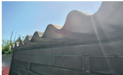
Links: Typische Welldachplatten aus Asbest. Mitte: Trennwand aus Asbest im Außenbereich. Häufig wurden Asbestplatten auch an Hausfassaden zur Isolierung verwendet. Fotos: Hanse- und Universitätsstadt Rostock
