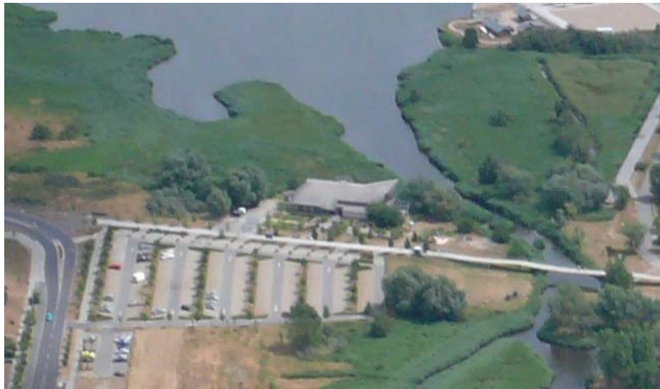
Abb. 86 Luftbild Eingang Nord
