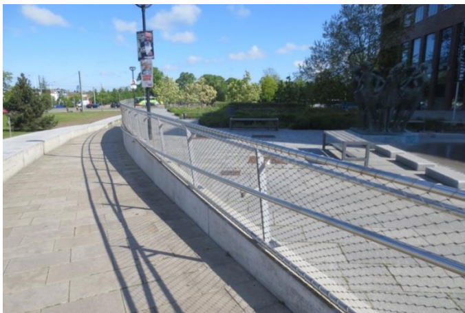
Bsp.: Zaunausführung vor dem Rostocker KTC mit Edelstahlmaschennetz
