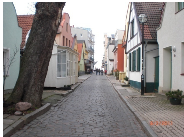
Bild 2: Wurzelbereich Baum vor Haus-Nr. 73
