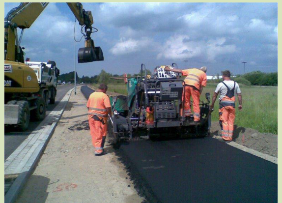
Asphaltierter Geh- und Radweg Neu Hinrichsdorf
