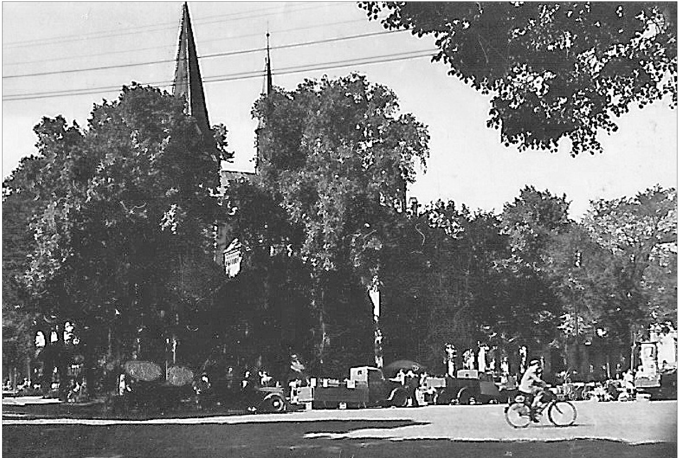
KIRCHENPLATZ 1956 (AMT FÜR DENKMALPFLEGE)
